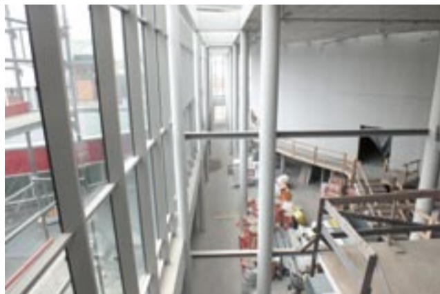
W środku budynku trwają obecnie prace wykończeniowe – montaż sufitów, instalacji, okładzin ściennych i kafelkowanie podłóg.
