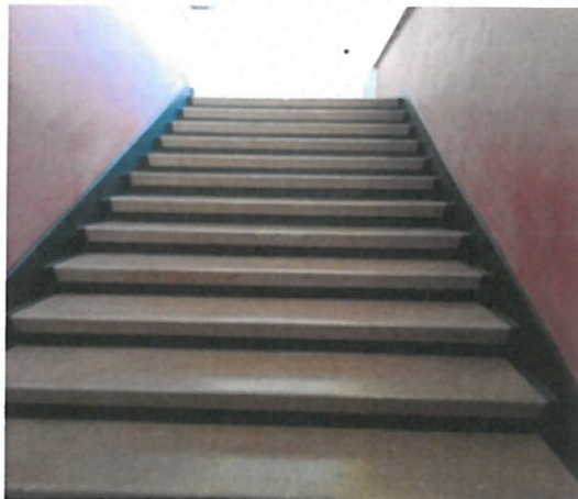
Fot. Stan po remoncie
