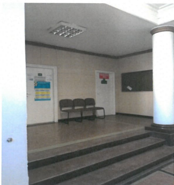
Fot. Stan przed remontem
