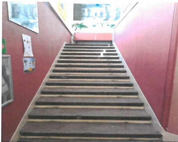
Fot. Stan przed remontem
