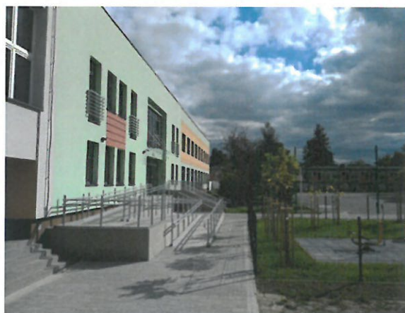
Fot. Budynek CUS
