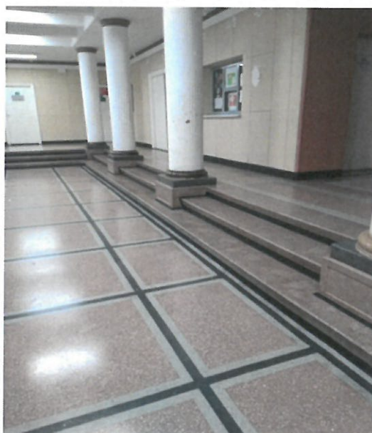
Fot. Stan po remoncie
