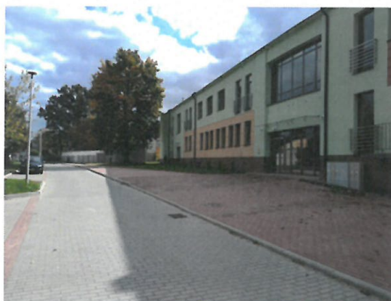
Fot. Budynek CUS
