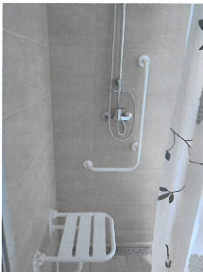
Fot. Montaż bielej armatury
