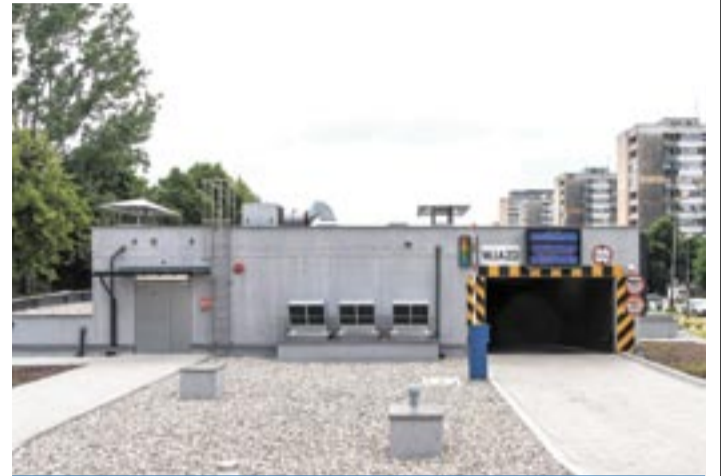
Podziemny parking przy stacji Tychy-Lodowisko.
