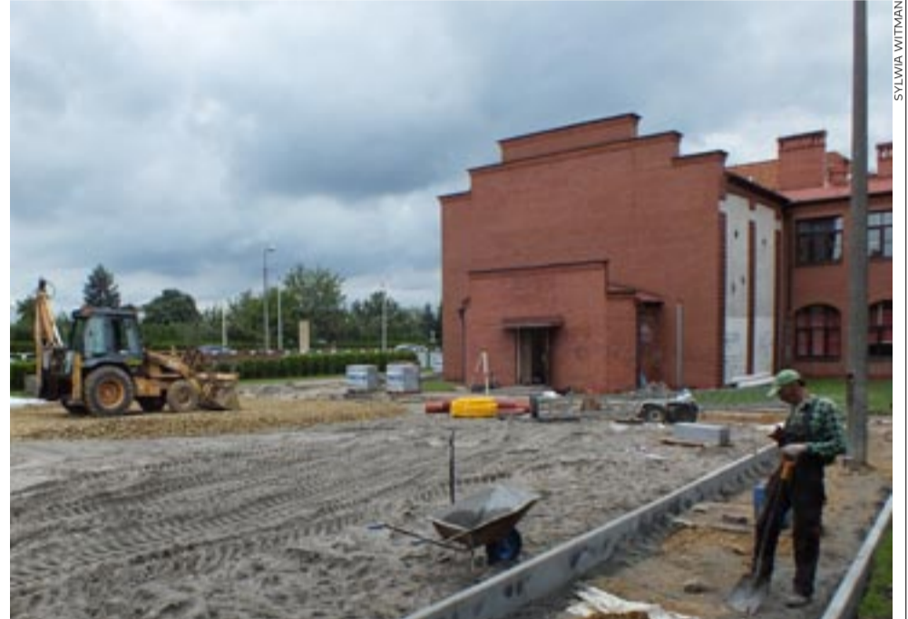
W połowie września mają zakończyć się prace na boisku przy SP nr 6 w Czułowie. Uczniowie będą mieli do dyspozycji nowe wielofunkcyjne boisko z bieżnią lekkoatletyczną i skocznią w dal.
