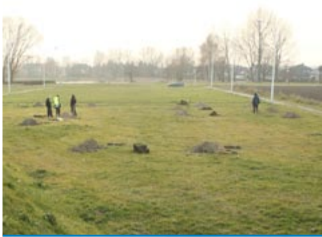
Obecnie trwa przygotowanie podłoża pod montaż urządzeń.
