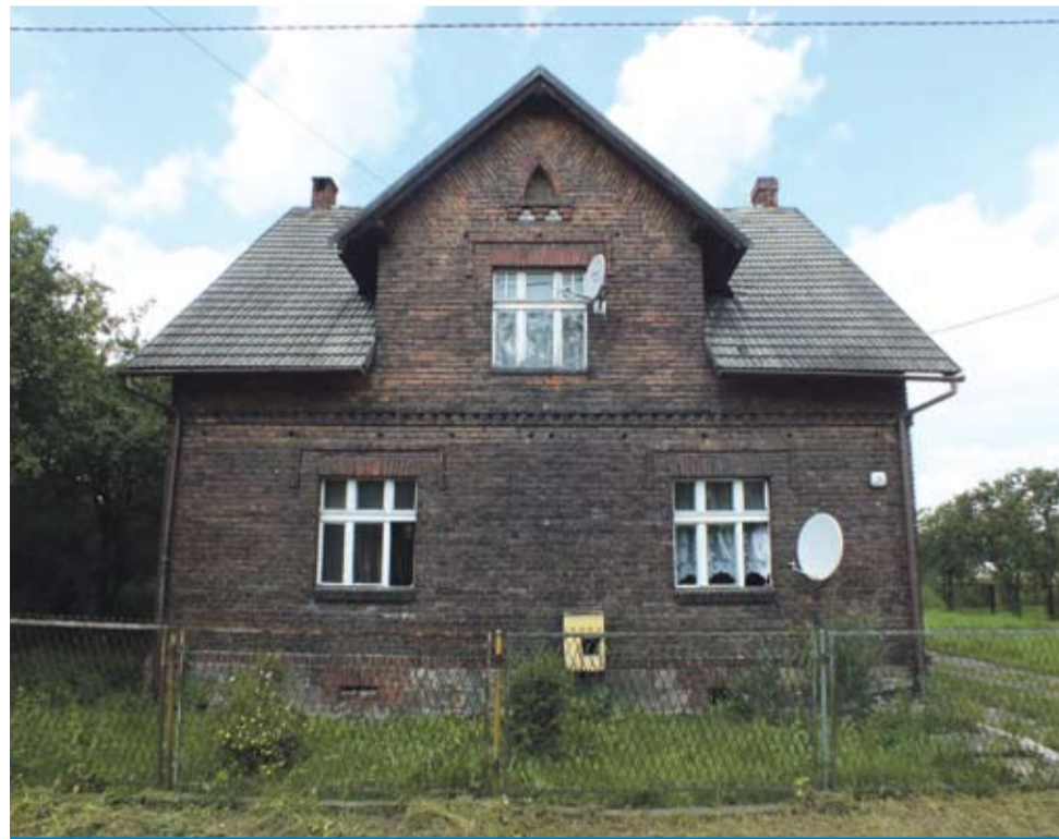
Dom przy ul. Wędkarskiej.
