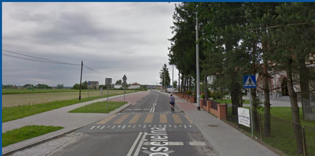
Wyniesione przejście dla pieszych przez ul. Kościelną
