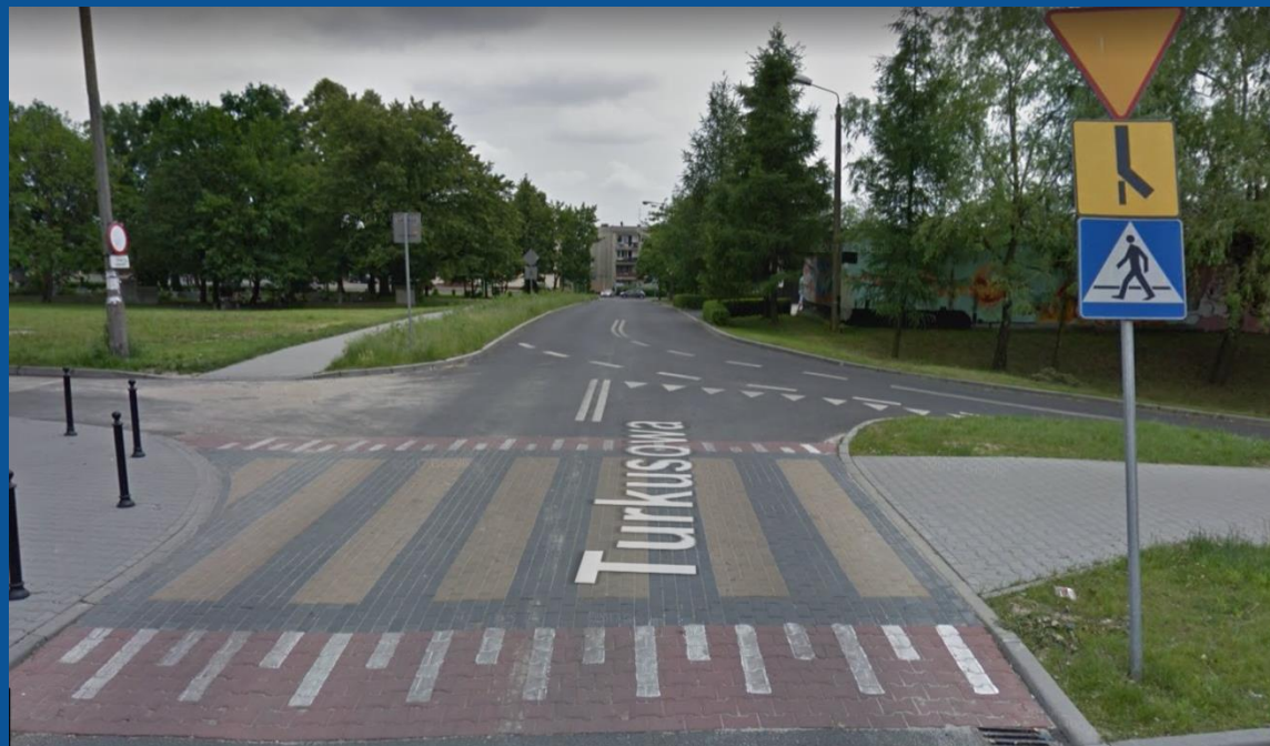
Wyniesione przejście dla pieszych przez ul. Turkusową
