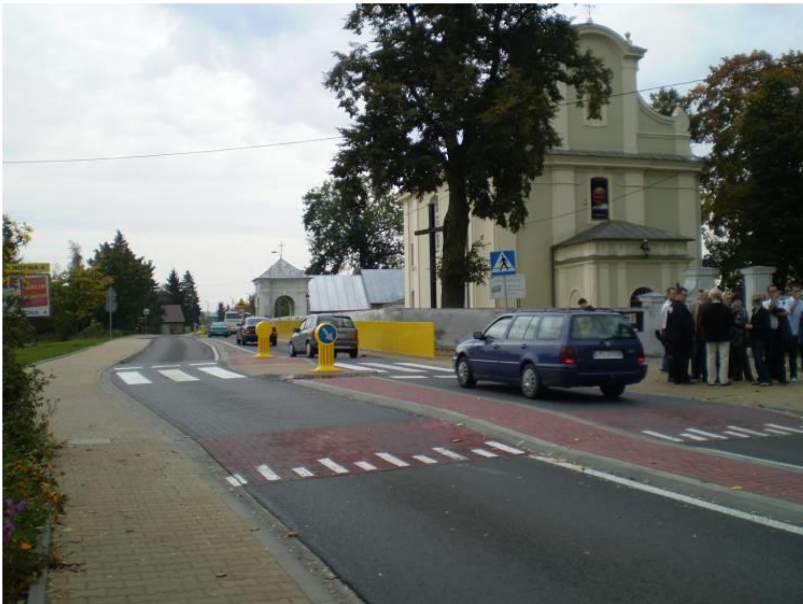
Wyniesiona powierzchnia w ciągu drogi wojewódzkiej nr 824 w Puławach.
