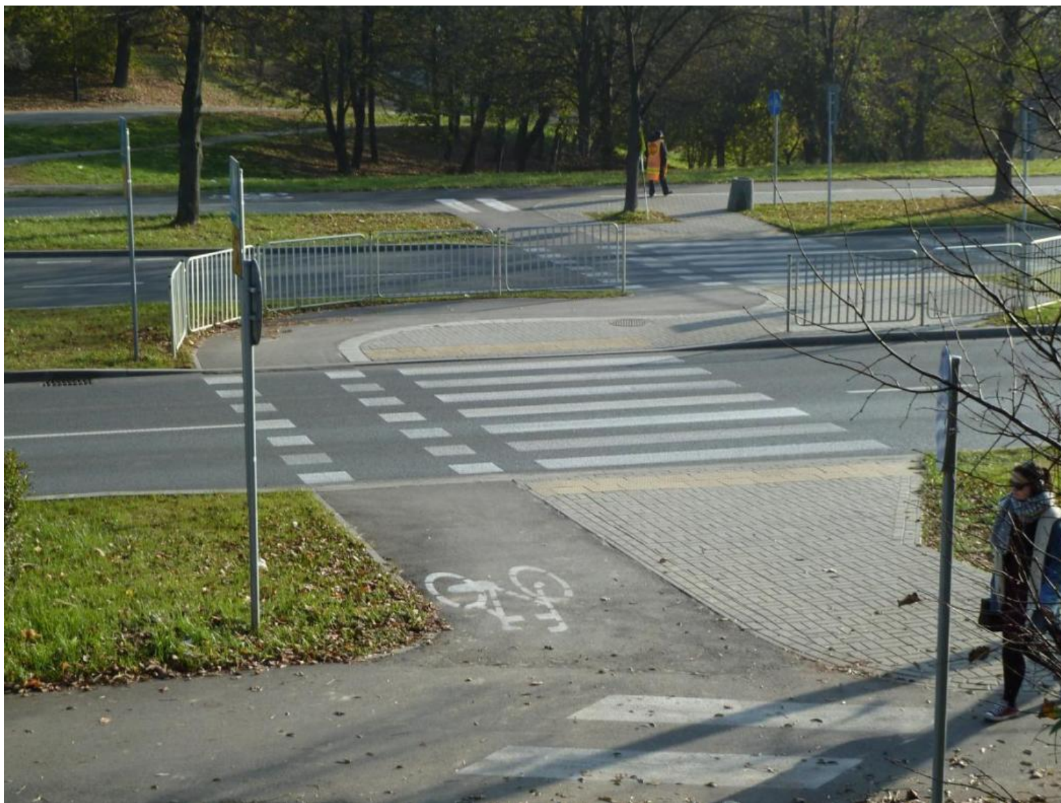
Przykład bezpiecznego prowadzenia ruchu pieszego i rowerowego przez pas dzielący jezdnię.
